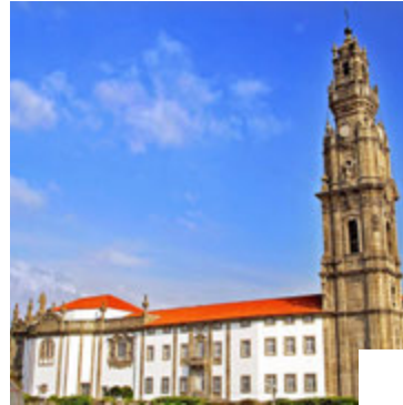
Réhabilitation du Complexe d'Édifices de l'Eglise et la Tour de Clérigos
