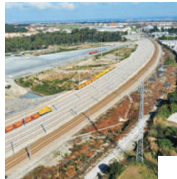
Liaison ferroviaire Porto-Aveiro. Aveiro, Portugal REFER SA Assistance technique maîtrise d'ouvrage, contrôle et approbation des plans, suivi et contrôle des travaux, coordination sécurité-santé sur chantier.
