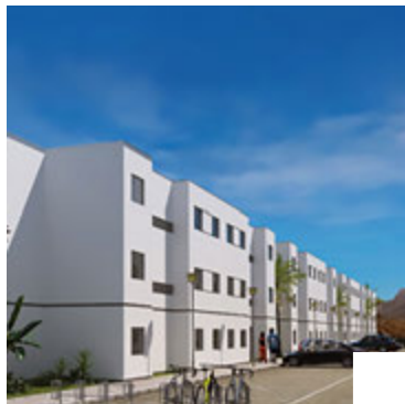
Construction de 36 logements sociaux à Boavista 1 Boavista - Cabo Verde Ministère de la Décentralisation, du Logement et de l'Aménagement du Territoire Assistance technique maîtrise d'ouvrage, contrôle et approbation des plans, suivi et contrôle des travaux, coordination sécurité-santé sur chantier.
