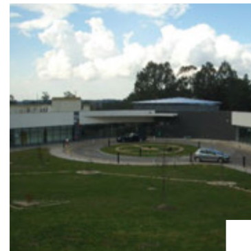
Dispensaire Dr. Arnaldo Sampaio Leiria, Portugal Autorité régionale de la santé Assistance technique maîtrise d'ouvrage, contrôle et validation des plans, suivi et contrôle des travaux, coordination sécurité-santé sur chantier.
