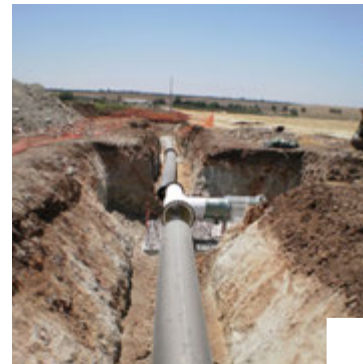
La construction de la conduite d'adduction des Cinco Reis
