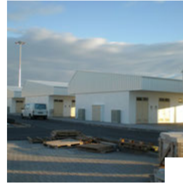
Construction des installations terrestres du petit port de pêche de Quarteira. Quarteira, Portugal IPTM - Instituto Português e Transportes Marítimos
