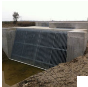
Construction de l'irrigation et de drainage secondaire Réseaux Réseau Bloc IV Hydroagricole Lezíria Exploiter Grande Vila Franca de Xira
