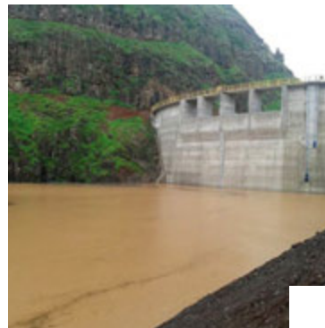
Construction du barrage de Saquinho, sur l'île de Santiago au Cap-Vert Ilha de Santiago, Cabo Verde Direction générale de la Planification, du Budget et de la gestion au Cap-Vert Assistance technique maîtrise d'ouvrage, contrôle et approbation des plans, suivi et contrôle des travaux, coordination sécurité-santé sur chantier.
