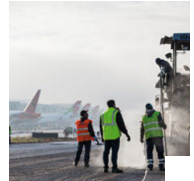
Réhabilitation de la piste 03.21 de l'Aéroport de Lisbonne. Lisboa, Portugal
