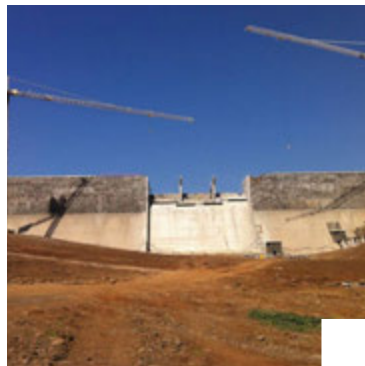
Construction du barrage de Salineiro, sur l'île de Santiago au Cap-Vert Ilha de Santiago, Cabo Verde Direction générale de la Planification, du Budget et de la gestion au Cap-Vert Assistance technique maîtrise d'ouvrage, contrôle et approbation des plans, suivi et contrôle des travaux, coordination sécurité-santé sur chantier.
