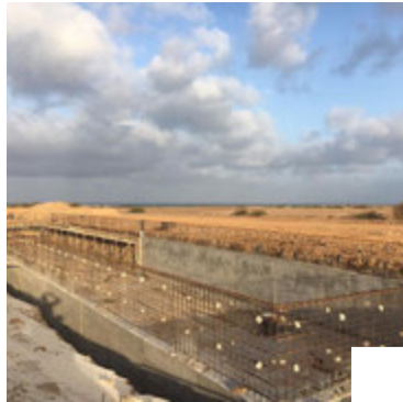
Exécution de l'assainissement dans la ville d'Espargos Ilha do Sal, Cabo Verde Armando Cunha Projet, inclus Avant Projet Sommaire, Avant Projet Détaillé, DAO et Assistance technique maîtrise d'ouvrage.
