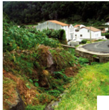
Régularisation du lit de la Grotta do Passal et augmentation de la section d'écoulement qui interfère avec la route nationale Açores, Portugal Direction Régionale de la Planification et des Ressources Projet, inclus Avant Projet Sommaire, Avant Projet Détaillé, DAO et Assistance technique maîtrise d'ouvrage.
