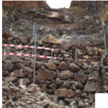
Construction du barrage Banca Furada et Réseau d'Adduction - Province de Ribeira Brava - Cap-Vert S. Nicolau, Cabo Verde Direction générale de la Planification, du Budget et de la gestion au Cap-Vert Assistance technique maîtrise d'ouvrage, contrôle et approbation des plans, suivi et contrôle des travaux, coordination sécurité-santé sur chantier.
