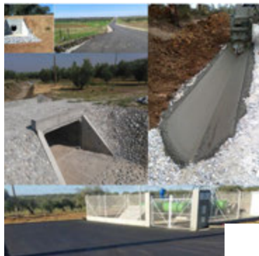
L'infrastructure d'irrigation, les travaux routiers et Moura Bloc Drainage Gravitational
