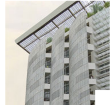
Bâtiment à usage mixte dans la Rua Amílcar Cabral N°21
