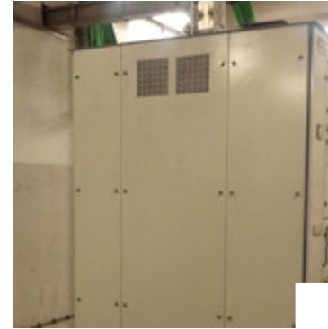
ALS - Plan de Développement - Transfert novas (Verrouillage et installation de the) Lisboa, Portugal ANA Aeroportos de Portugal S.A Assistance technique maîtrise d'ouvrage, contrôle et approbation des plans, suivi et contrôle des travaux, coordination sécurité-santé sur chantier.
