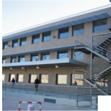
Nouveau complexe du fret de l'aéroport de Lisbonne Lisboa, Portugal ANA Aeroportos de Portugal S.A Assistance technique maîtrise d'ouvrage, contrôle et validation des plans, suivi et contrôle des travaux, coordination sécurité-santé sur chantier.
