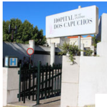
Construction de l'hôpital sous-groupe Capuchos / Desterro Lisboa, Portugal Centro Hospitalar de Lisboa Audit des travaux d'une valeur de plus de 10.000 au cours des années 2001, 2002 et 2003
