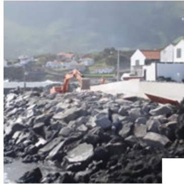
Réparation et renfort du littoral sur le chemin du phare - prainha de S. Roque. Ilha do Pico, Açores Secretaria Regional do Ambiente e do Mar - DROTRH
