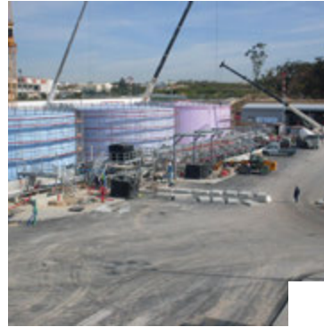
ALS - Plan de Développement - Transfert GOC (Verrouillage et installation de support) Lisboa, Portugal ANA Aeroportos de Portugal S.A Assistance technique maîtrise d'ouvrage, contrôle et approbation des plans, suivi et contrôle des travaux, coordination sécurité-santé sur chantier.
