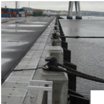
Prolongement du quai des cargaisons solides en vrac du port de Figueira da Foz Figueira da Foz, Portugal Institut de Transports maritimes et portuaires
