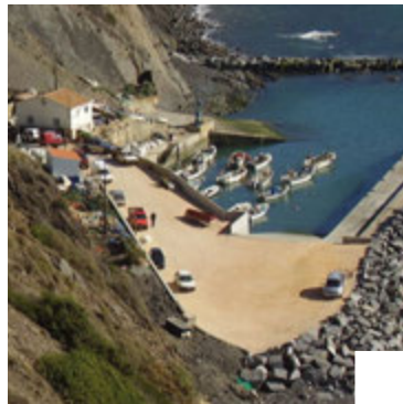
Travaux d'amélioration dans le port d'Arrifana Aljezur, Portugal Mairie d'Aljezur
