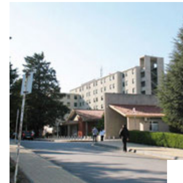
Centre hospitalier de Vila Real - Peso da Régua Vila Real, Portugal Centre hospitalier de Vila Real Assistance technique maîtrise d'ouvrage, contrôle et validation des plans, suivi et contrôle des travaux, coordination sécurité-santé sur chantier.
