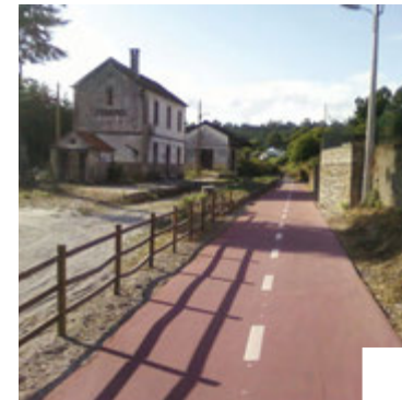
Aménagement paysager pour adapter l'ancienne plateforme ferroviaire de la ligne de Viseu (ex ligne de la région de Dão), localisée dans les limites de la région de Tondela, en écopiste. Tondela, Portugal REFER SA Assistance technique maîtrise d'ouvrage, contrôle et approbation des plans, suivi et contrôle des travaux, coordination sécurité-santé sur chantier.
