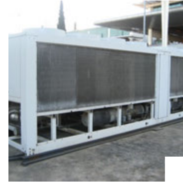
Aéroport de Lisbonne - unification de la centrale à froid n°2 Lisboa, Portugal ANA Aeroportos de Portugal S.A Assistance technique maîtrise d'ouvrage, contrôle et approbation des plans, suivi et contrôle des travaux, coordination sécurité-santé sur chantier.
