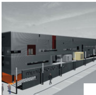
Adaptation et transformation de l'ancien bâtiment de l'École secondaire en mairie Aljezur, Portugal
