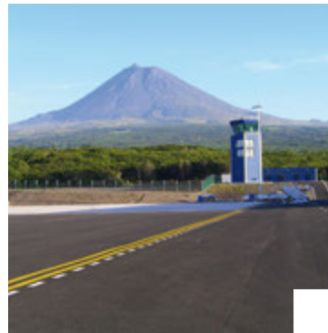
Fourniture et installation de l'équipement de signalisation lumineuse de la piste de l'Aéroport de l'Île du Pico Açores, Portugal Sata - Air Açores Assistance technique maîtrise d'ouvrage, contrôle et approbation des plans, suivi et contrôle des travaux, coordination sécurité-santé sur chantier.
