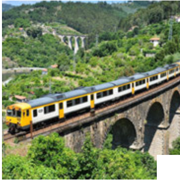
Adéquation des structures d'électrification, des bâtiments techniques et de l'élévation des quais de la ligne Douro Douro, Portugal Infraestruturas de Portugal, SA Projet, inclus Avant Projet Sommaire, Avant Projet Détaillé, DAO et Assistance technique maîtrise d'ouvrage.
