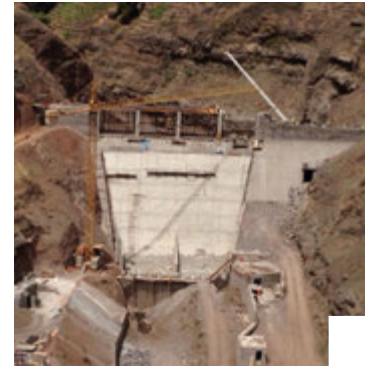
Construction du barrage Canto Cagarra et Réseau d'Adduction - Province de Ribeira Brava - Cap-Vert Ilha de Santo Antão, Cabo Verde Direction générale de la Planification, du Budget et de la gestion au Cap-Vert Assistance technique maîtrise d'ouvrage, contrôle et approbation des plans, suivi et contrôle des travaux, coordination sécurité-santé sur chantier.
