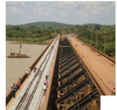
Matala barrage dans la province de Huila en Angola
