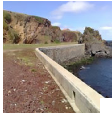
Protection du littoral de Santa Cruz das Flores - Travaux d'urgence. Ilha das Flores, Açores DROTRH
