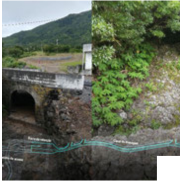
Fossé pour collecter et détourner les écoulements caudaux dans la section entre Ribeira do Dilúvio et Ribeira da Prainha, y compris le reprofilage du passage hydraulique Açores, Portugal Direction Générale de l'Environnement Projet, inclus Avant Projet Sommaire, Avant Projet Détaillé, DAO et Assistance technique maîtrise d'ouvrage.
