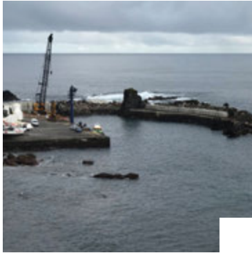
Requalification du "Porto das Poças", à "Santa Cruz das Flores", pour augmenter la Capacité de Transports de Passagers Santa Cruz das Flores, Açores Port des Açores
