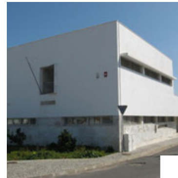
Dispensaire de Viana do Alentejo Viana do Alentejo, Portugal Autorité régionale de la santé Assistance technique maîtrise d'ouvrage, contrôle et validation des plans, suivi et contrôle des travaux, coordination sécurité-santé sur chantier.
