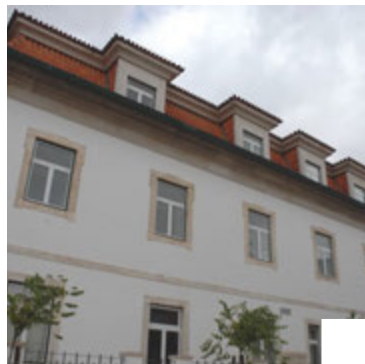
Rénovation de l'hôpital Dr. Manuel de Aguiar Leiria, Portugal Santa Casa da Misericórdia de Leiria Assistance technique maîtrise d'ouvrage, contrôle et validation des plans, suivi et contrôle des travaux, coordination sécurité-santé sur chantier.
