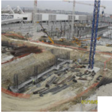
ALS - Plan de Développement - nouveau Busgate Nord - augmentation des terminaux à bagages - structures et fondations Lisboa, Portugal ANA Aeroportos de Portugal S.A Assistance technique maîtrise d'ouvrage, contrôle et approbation des plans, suivi et contrôle des travaux, coordination sécurité-santé sur chantier.
