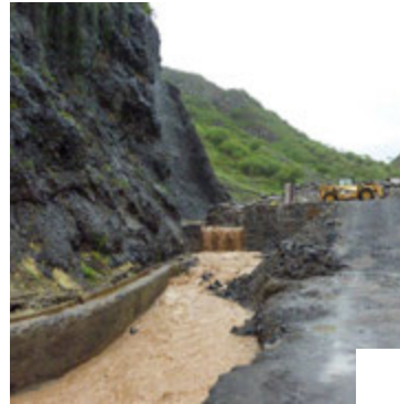
Construction du barrage de Figueira Gorda et Réseau d'Adduction - Comté de Santa Cruz - Cap-Vert Santiago, Cabo Verde Direction générale de la Planification, du Budget et de la gestion au Cap-Vert Assistance technique maîtrise d'ouvrage, contrôle et approbation des plans, suivi et contrôle des travaux, coordination sécurité-santé sur chantier.
