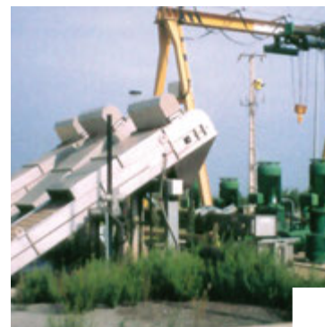
Réseaux d'irrigation, voies de circulation et drainage du bloc 1 de la réhabilitation de l'aménagement hydro-agricole de Roxo
