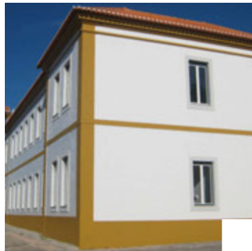
Reconstruction de l'hôpital Conde bracial Santiago do Cacém, Portugal Santa Casa da Misericórdia de Santiago do Cacém Assistance technique maîtrise d'ouvrage, contrôle et validation des plans, suivi et contrôle des travaux, coordination sécurité-santé sur chantier.
