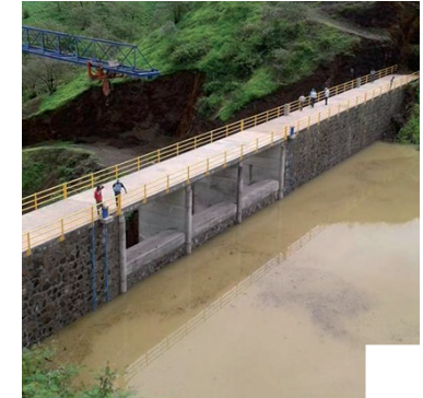
Construção das Barragem de Faveta Ilha de Santiago, Cabo Verde
