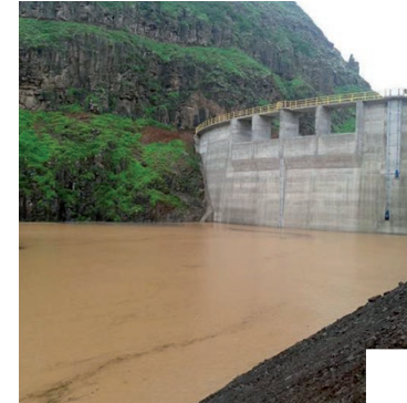
Construção das Barragem de Saquinho Ilha de Santiago, Cabo Verde
