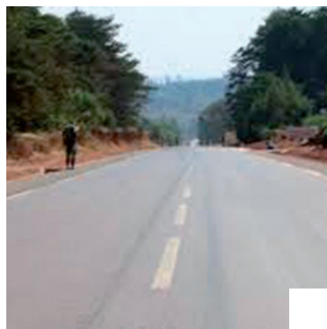
Reabilitação da estrada Makebuko-Ruyigi (RN13) e obras connexas. Burundi
