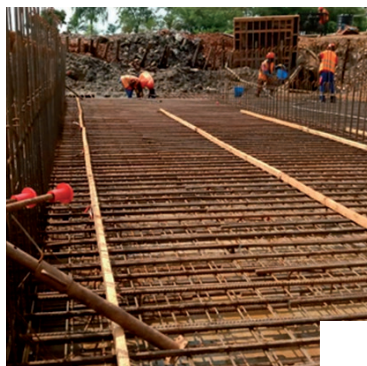
Construção de uma ponte sobre o Rio Rusizi, na fronteira entre o Burundi e a República Democrática do Congo (RN 4 PK 15 457). Burundi
