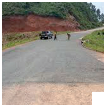
Reabilitação do eixo transfronteiriço RN4 entre o Burundi e a fronteira da RDC Burundi
