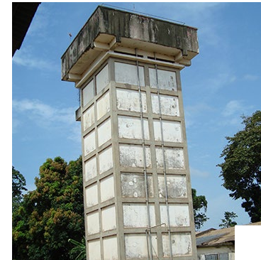
Reabilitação e extensão das redes / reservatórios de água e electricidade em Bissau Guiné Bissau
