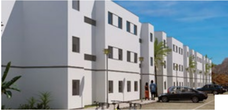
Construção de 36 Habitações de Interesse Social em Boavista 1 Boavista - Cabo Verde
