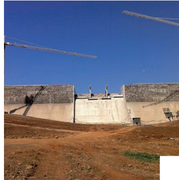
Construção das Barragem de Salineiro Ilha de Santiago, Cabo Verde
