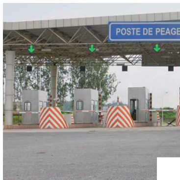
Estudo Técnico e Supervisão da Construção da Praça de Portagem na Estrada RN1 Burundi
